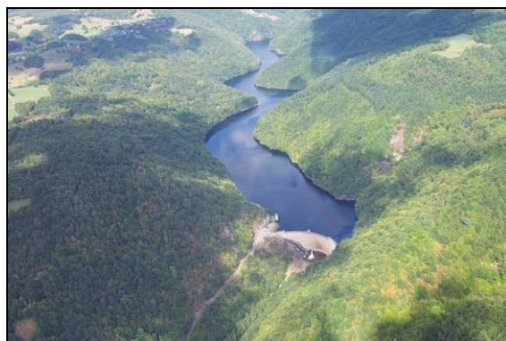
Photo 1. Barrage de Hautefage sur la Maronne
