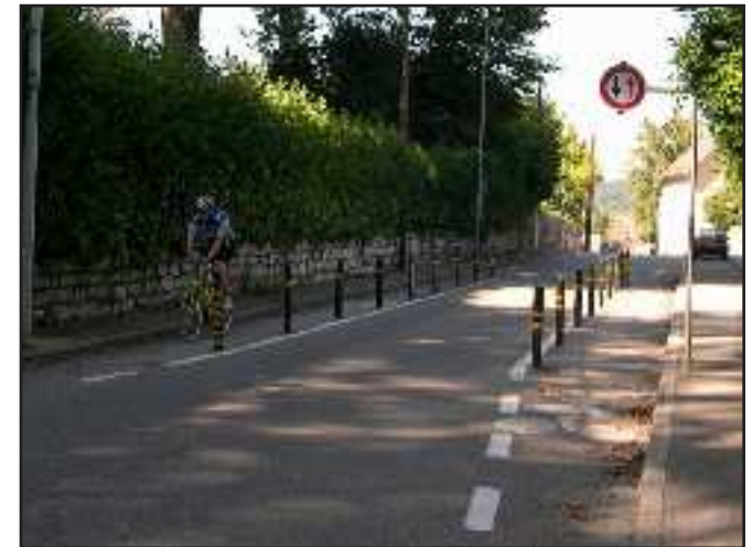
Dispositif de ralentissement des voitures de type «écluse» (avec des potelets) non pénalisant pour les vélos
