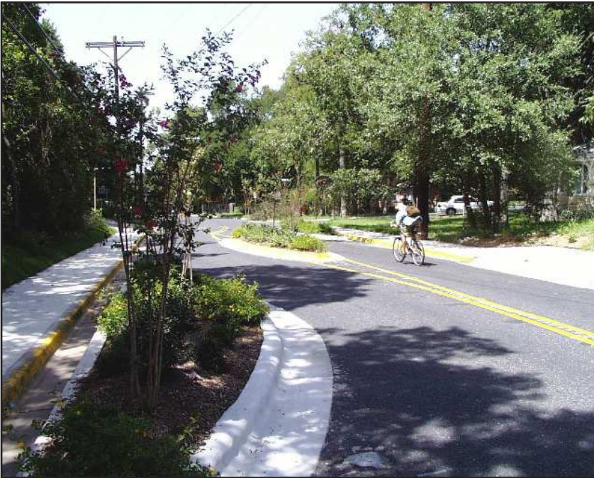
Exemple de chicane, par contre celle-ci ne présente pas de by-pass à vélo!
