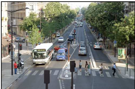
Couloir bus bidirectionnel latéral sur le boulevard de Magenta (Paris 10e Ardt).
