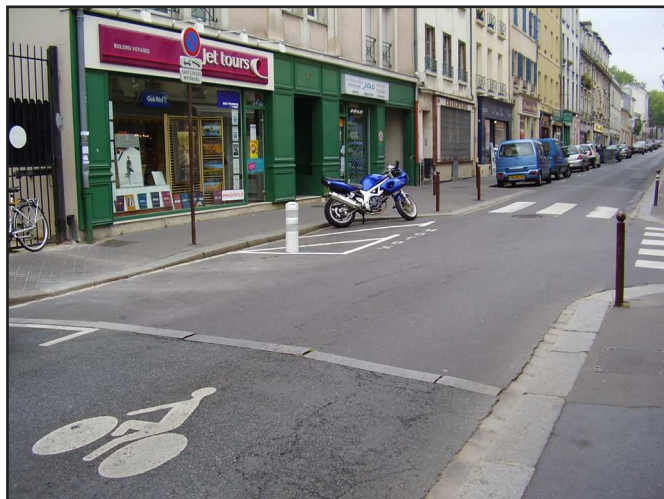
Traitement d'une intersection avec des bordures noyées. Source: Photo personnelle.
