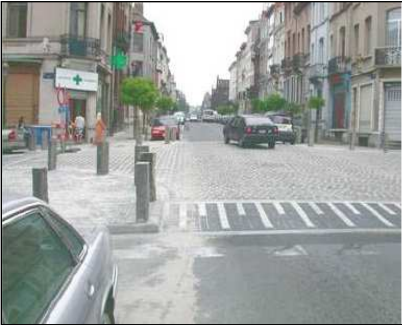
Exemple de plateau avec revêtement en pavés, sans passage piéton, dans un carrefour. ( Belgique) Source: www.provelo.org
