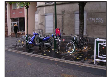
Avancée de trottoir en pavés pour délimiter le stationnement et avec une bonne installation de U standards pour accrocher les vélos (photo en bas à droite)
