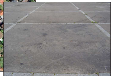
Dallage de la chaussée
