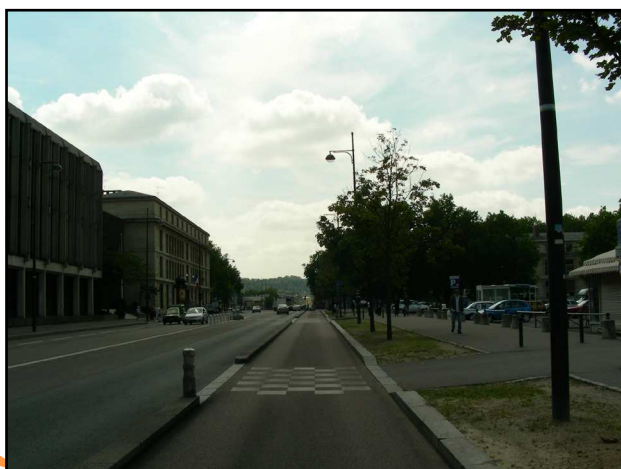
Couloir avec séparateur infranchissable en direction de l'avenue de Paris.
