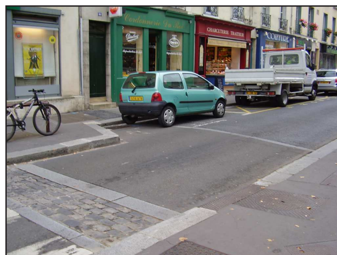
Traitement d'un passage piéton avec avancée de trottoir. Source: Photo personnelle.
