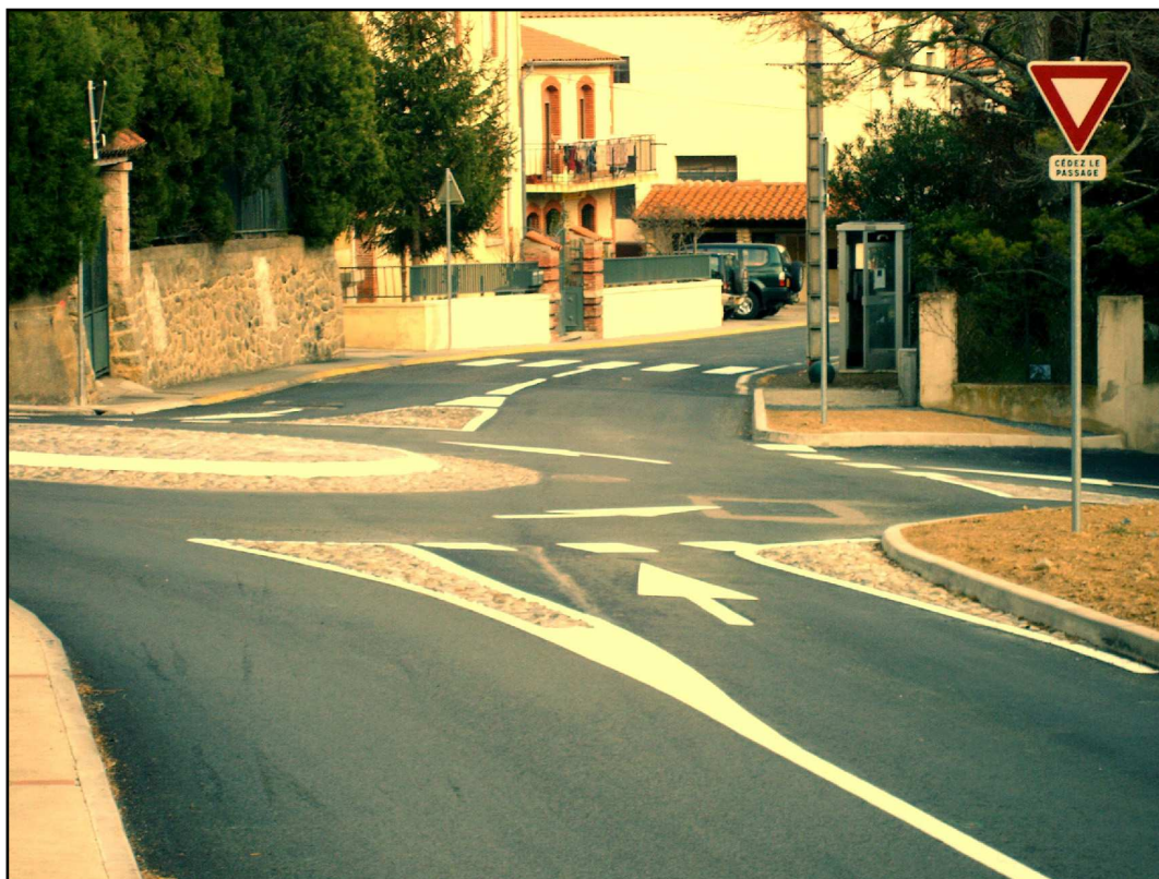
Mini-giratoire aux abords d'une école à Catllar (située en Conflent).
