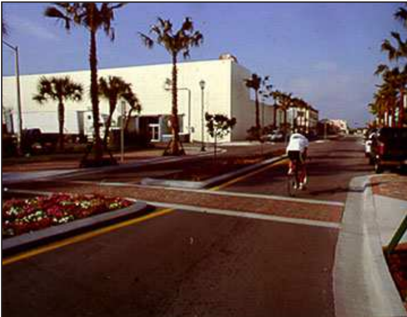
Refuge central avec parterres fleuris et passage piéton matérialisé par des pavés de couleur proche de celle de la chaussée.
