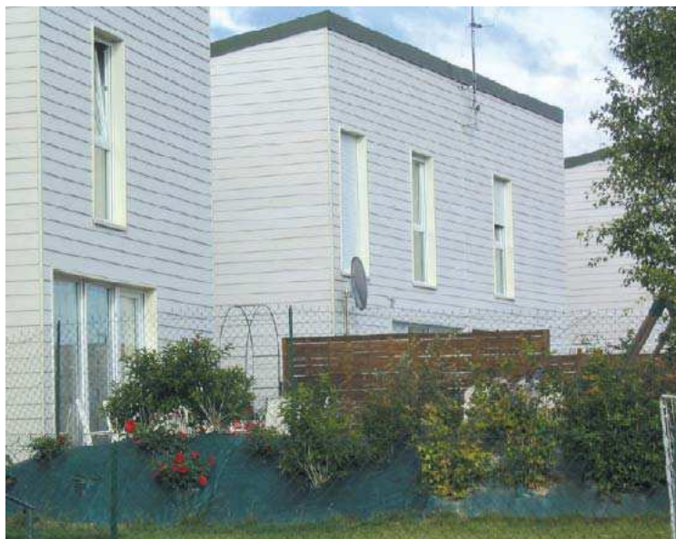
Photo n°4 : Les maisons à ossature bois de la cité jardin
