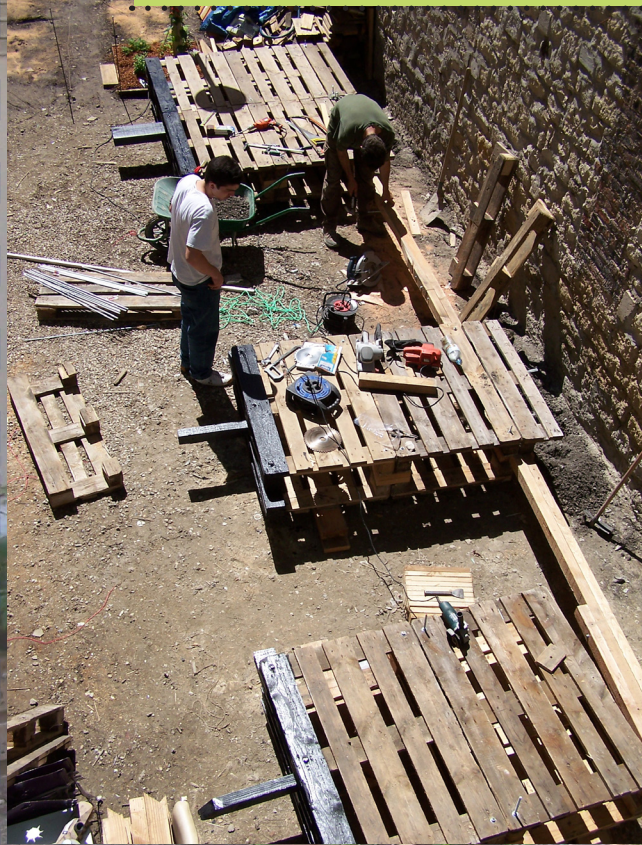
Montage du deuxième mur de voisinage
