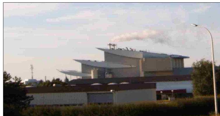
Figure 10 : Le Centre multifilière de valorisation de déchets de la région de Blois
