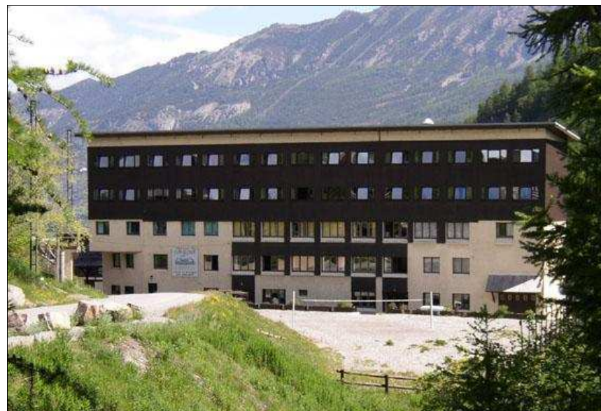
Figure 12 : Bâtiment 1 des Carlines à Vars-les-Claux [16 juin 2004] http://www.carlines-vars.com
