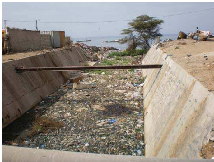
Photo 14: Embouchure du canal IV au niveau de Soumbédioune
