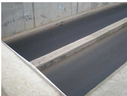
Photo 17: Route de la Corniche vue du haut de la trémie de la Porte du Millénaire.
