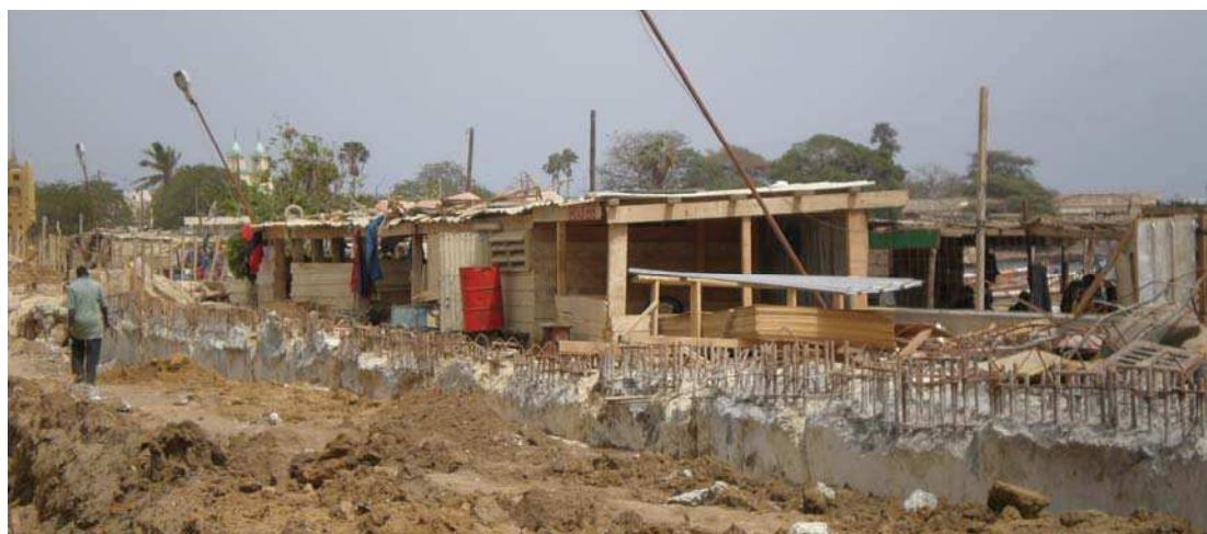
Photo 20: Parois moulées du tunnel sortant de terre.
