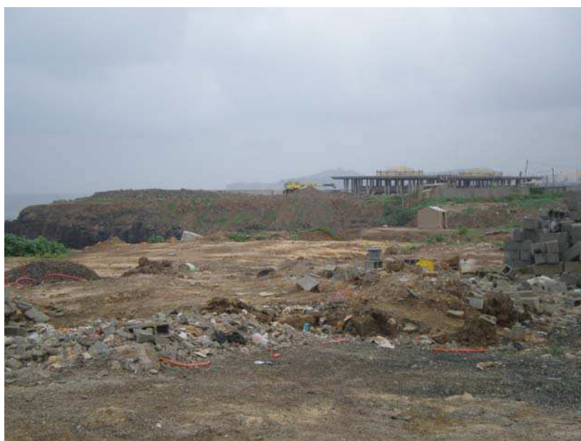
Photo 22 : Hôtel Sea Plaza en construction au niveau de la Corniche
