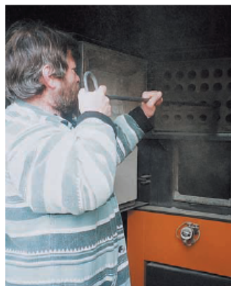
Nettoyage du réseau de tubes de fumée.
