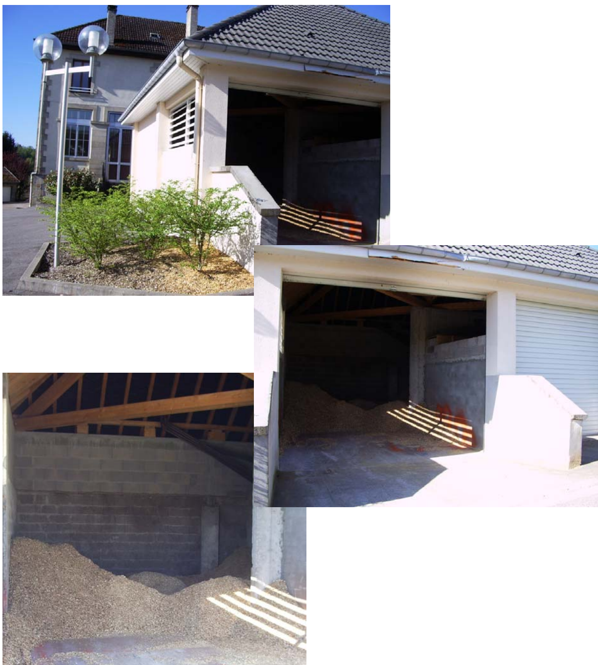
Photo n° 1, 2 et 3 : La chaufferie bois d'Uzemain
