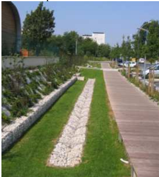
Exemple de tranchée drainante
