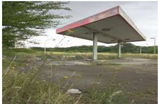
Photo 1 : Exemple de station service à l'abandon. Source : www.tomshardware.fr
