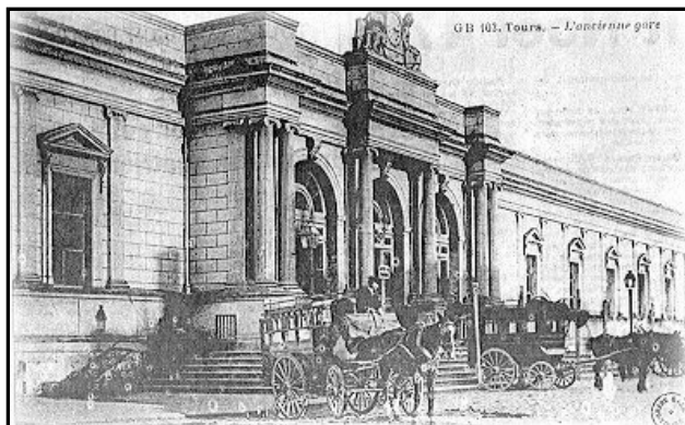
Photo de la façade Nord de l'ancienne gare
