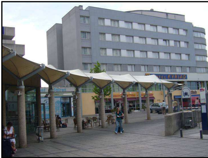
Arrêt 1, Photo 1 : Les colonnes
