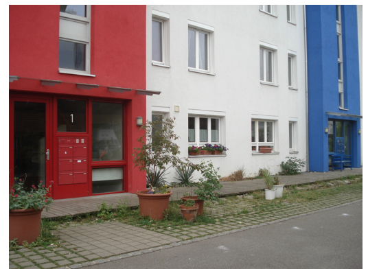
Délaissé de 2m, Rieselfeld
