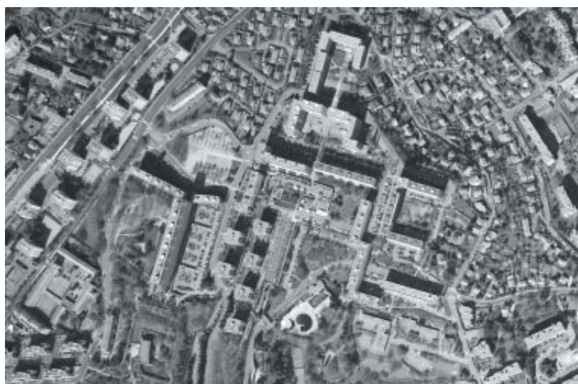
Photo 8 Vue aérienne de la zone centrale du quartier de Montessuy
