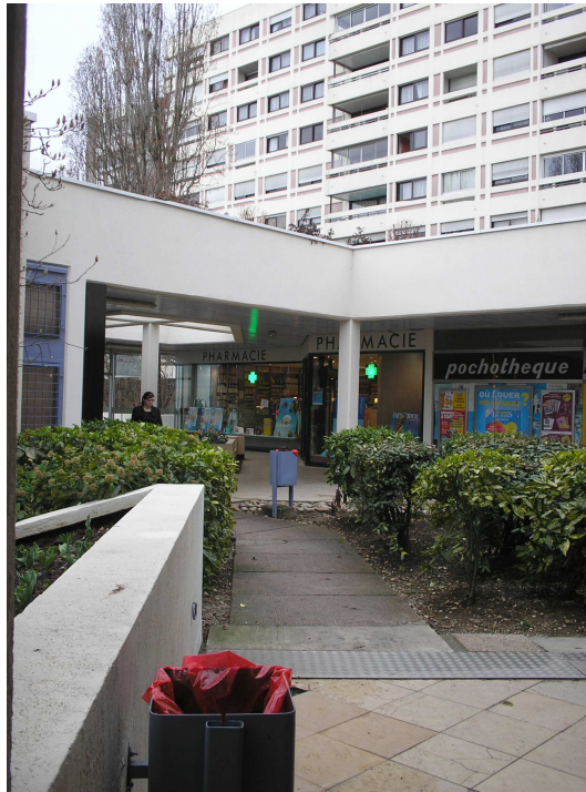
Photo 30 Vue de l'intérieur du centre commercial Réalisation personnelle
