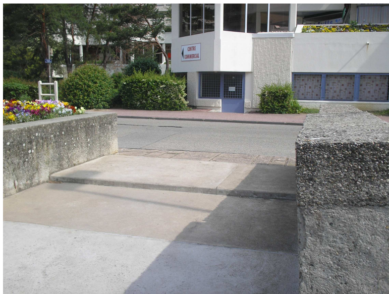
Photo 18 Vue de la marche à la sortie de l'escalier venant du parking de la piscine et des trottoirs le long de la rue Benjamin Delessert
