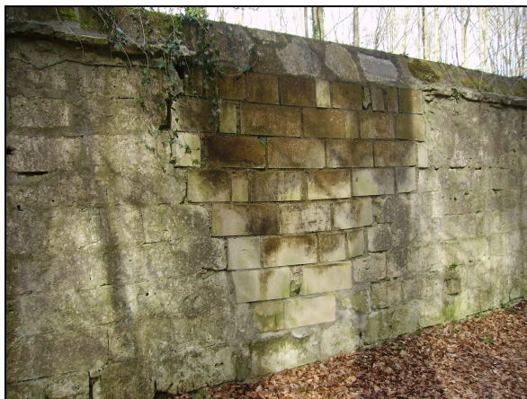
Photo n°15 : Mur d'enceinte restauré Source personnelle
