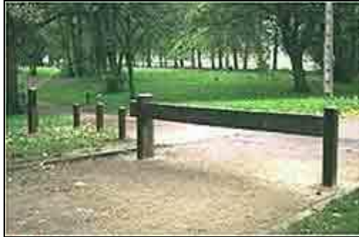
Photo n°20 : Barrière forestière à placer aux entrées principales du Parc pour empêcher l'accès des véhicules
