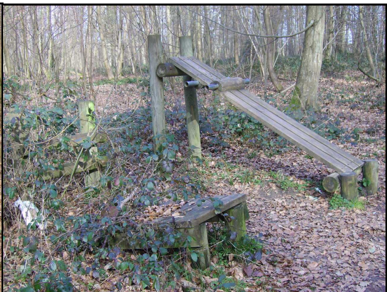
Photo n°5 : Agrès dégradé et envahi par les ronces Source personnelle
