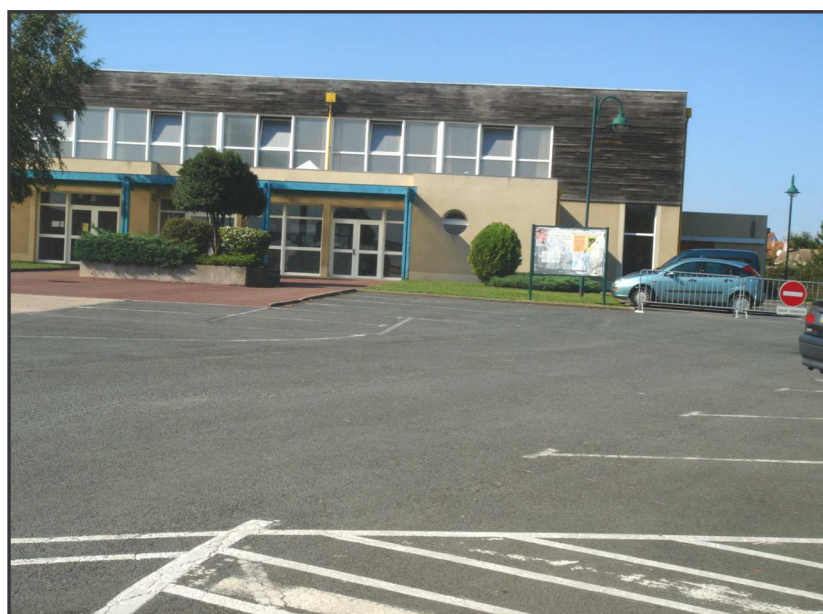
Photo 14 : Large voirie délimitée seulement par des marquages au sol
