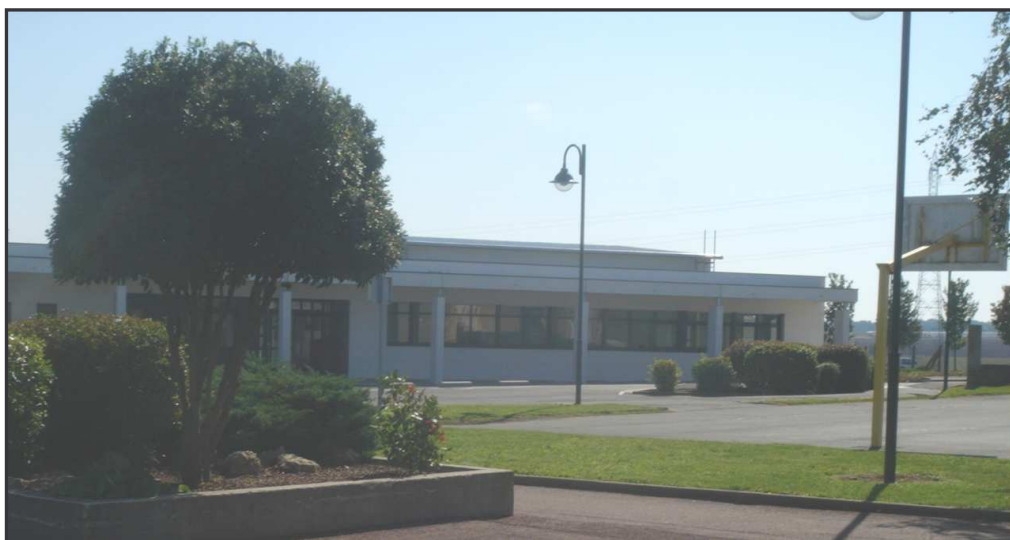
Photo 2 : Nouvelle cantine scolaire
