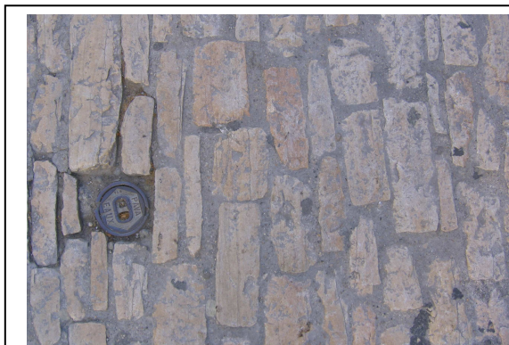
Doc.46: Pavés marquant l'intersection entre une zone piétonne et une rue ouverte à la circulation
