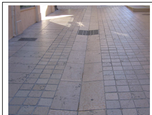
Doc.47: Dallage de la rue semi-piétonne
