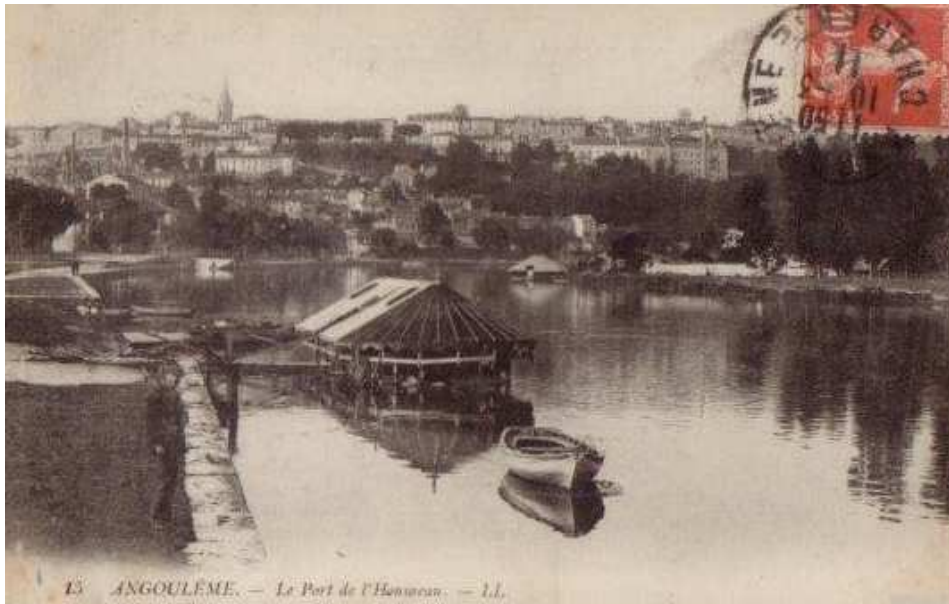
Photo n°1 : le port de l'Houmeau avant sa réhabilitation
