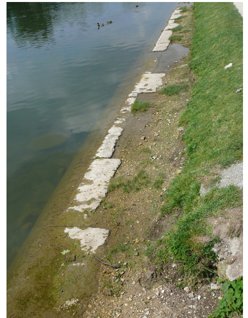
Photo n°22 : le port de l'Houmeau avant les travaux
