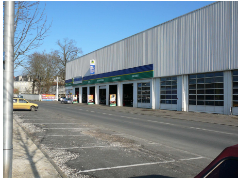
Photo n°43 : le garage Euromaster est construit en métal
