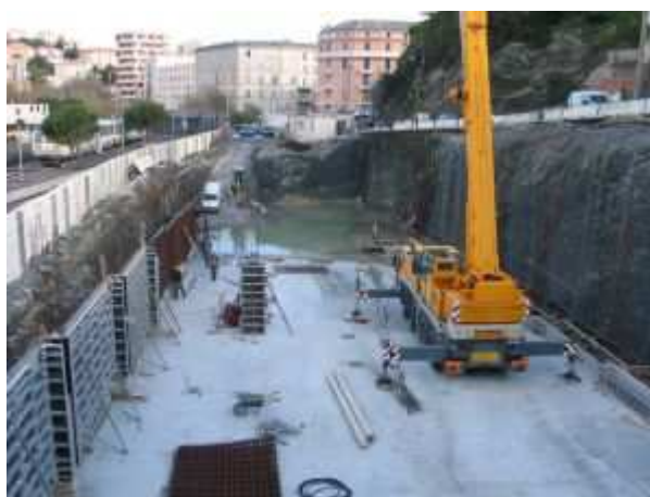
La création d'un parking souterrain (Fig. 31)
