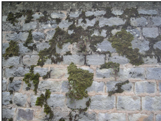
Photo 19 : Parapet incrusté de mousses
