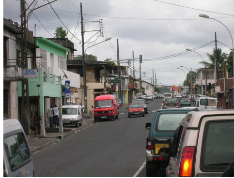
Illustration 21 : Eclairage vétuste et réseaux aériens
