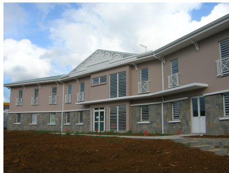
Illustration 34 : Nouveau bâtiment abritant une entreprise de BTP dans un quartier limitrophe de Sainte-Thérèse
