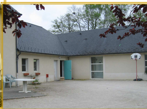
Photo n°3 : vue à droite de l'entrée
