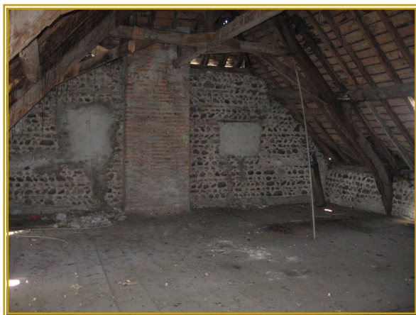
Photo n°36: grenier avec charpente traditionnelle
