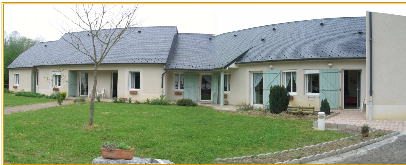
Photo n°1 : vue à gauche de l'entrée de la MARPA. partie logements de plain-pied avec sorties vers la cour.
