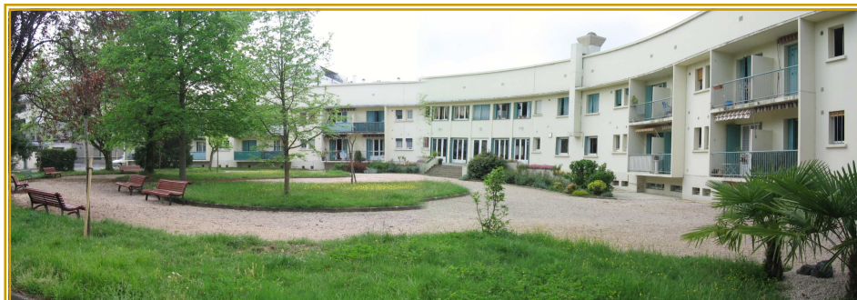
Photo n°13 : le parc et le premier bâtiment du foyer-logement
