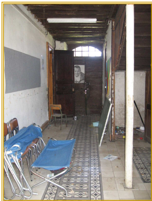
Photo n°30 : Hall d'entrée avec la mosaïque, le plafond « à la française », le départ de l'escalier
