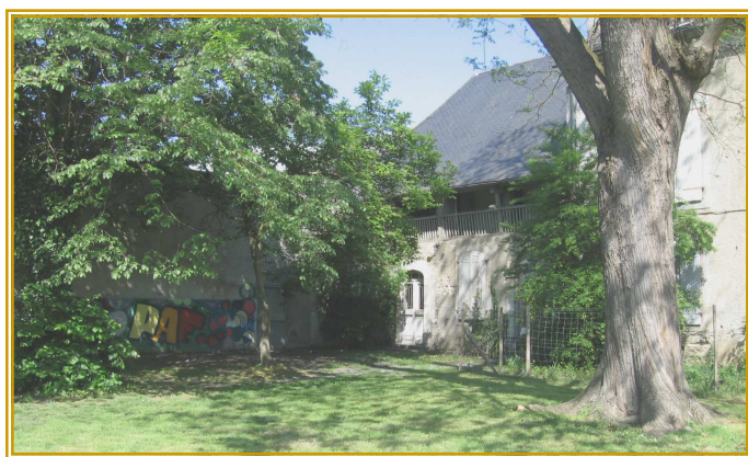
Photo n°28 : façade avant (sud) de l'annexe
