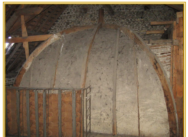
Photo n°37: charpente particulière sur dôme de l'escalier
