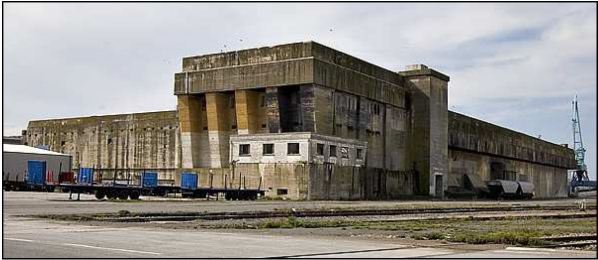
Figure 10 : Vue Nord- Est de la base
