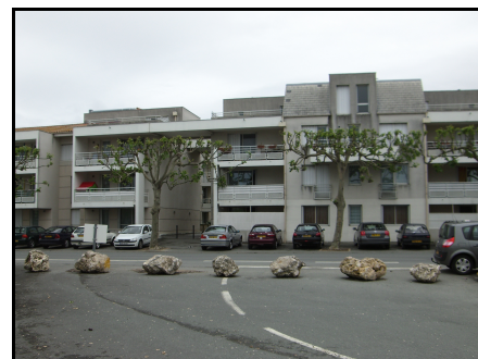
Figure 46: Aperçu de l'entrée de la voie d'accès
