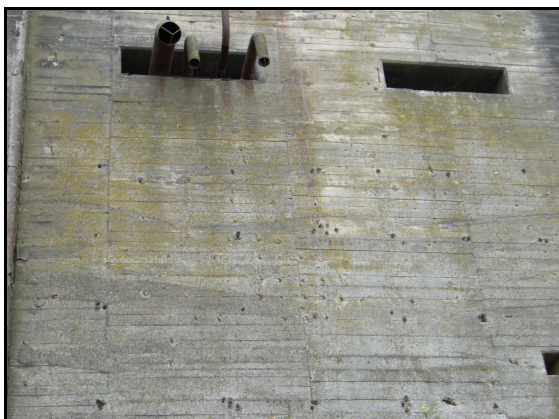
Figure 41: Zoom sur la façade Nord de la base
