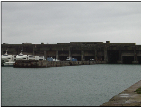
Figure 36: Vue Sud-Ouest de la base
