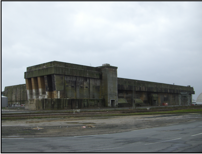
Figure 26 : Vue Nord-Est de la base
