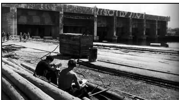
Figure 29: Juillet 1942 lors de la construction de l'U-bunker.
