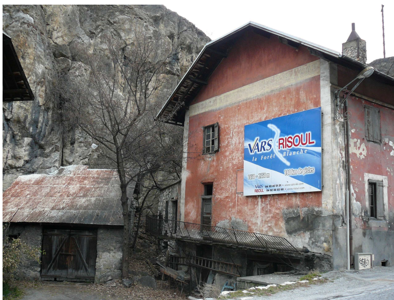
Figure 27 : Bâtiment à l'extrémité Sud de la traversée
