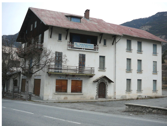
Figure 29 : Un bâtiment qui cherche acquéreur depuis trop longtemps: le numéro de téléphone ne comporte encore que 8 chiffres !
