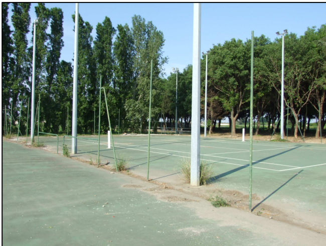
Observation du centre de la zone bétonnée vers le Nord-Est Réalisation personnelle
