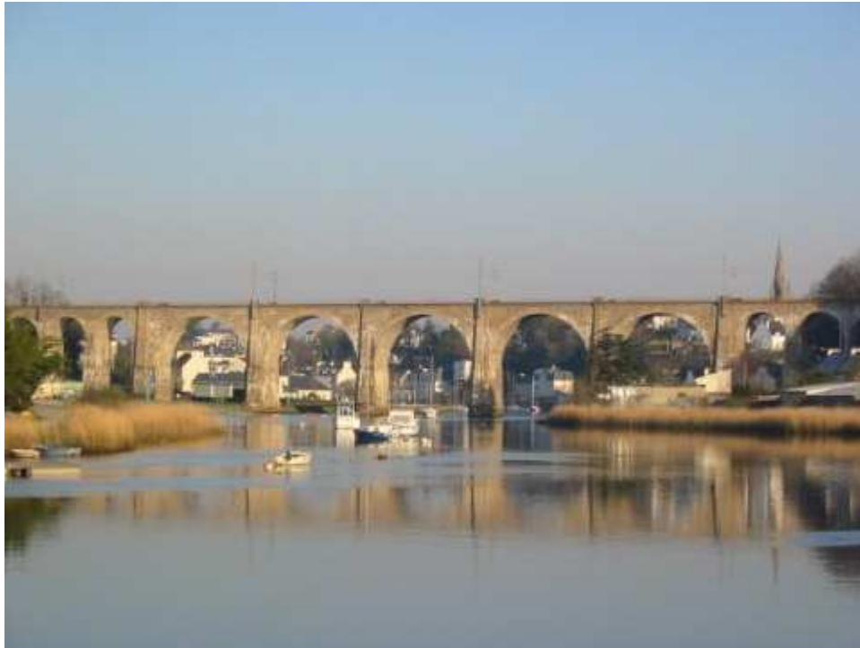
Photo 12 : Viaduc du chemin de fer au dessus du Blavet au sud du centre-ville
