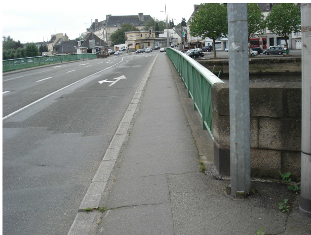
Photo 8 : Pont routier Jeanne la Flamme
