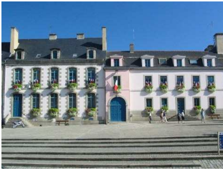
Photo 5 : Vue sur la mairie d'Hennebont à partir de la place pavée Foch récemment rénovée
