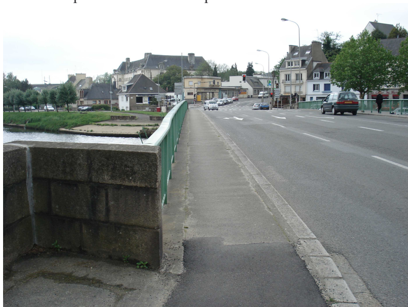
Photo 11 : Pont routier Jeanne la Flamme
