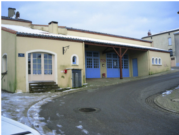
Photo 7 : Façade Est de la Salle des Fêtes
