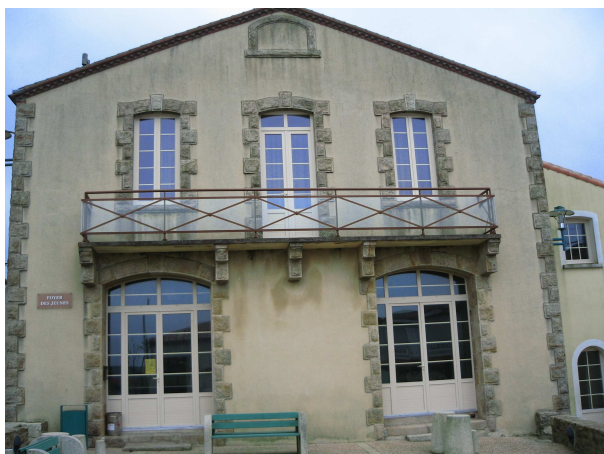
Photo 19 : Façade Sud du Foyer des Jeunes
