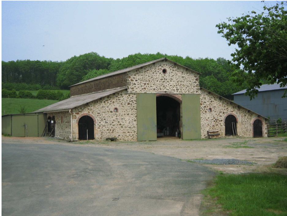
Photo 21 : Grange de l'Eperon
