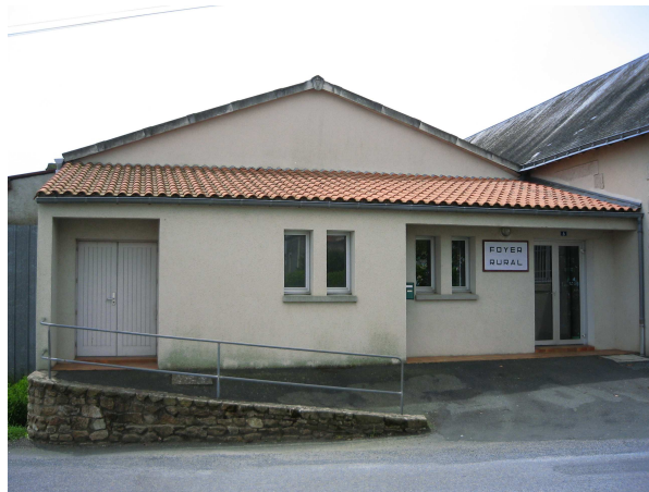
Photo 15 : Façade Nord du Foyer Rural
