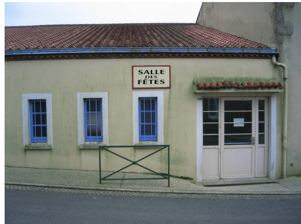
Photo 8 : Façade Ouest de la Salle des Fêtes
