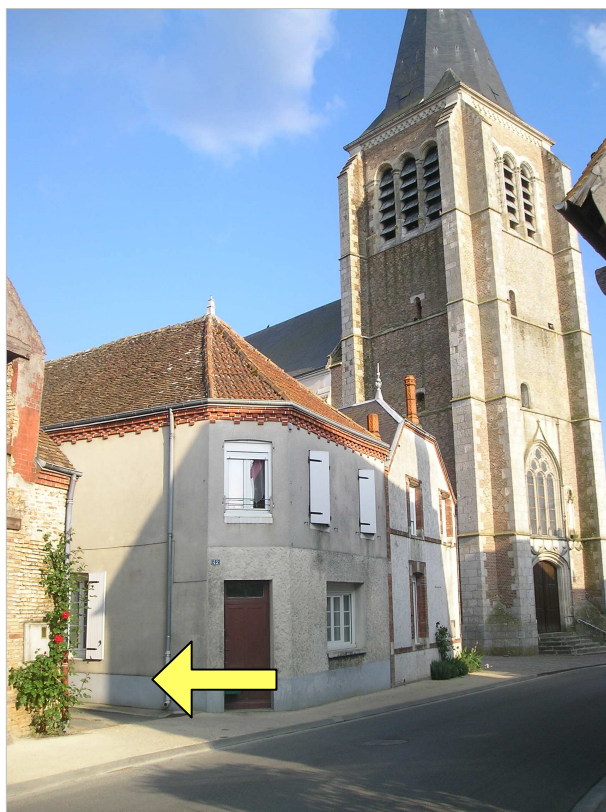
Photo 12 : accès à la Rue des Petits Souliers par la Grande Rue.
