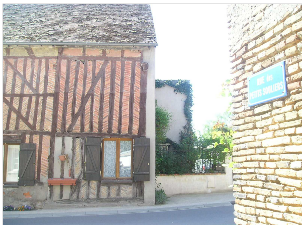
Photo 24 : architecture Solognote à la sortie de la rue des Petits Souliers.
