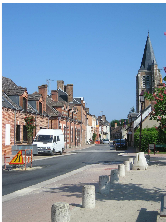
Photo 5 : la Grande Rue : travaux et revêtement du sol.
