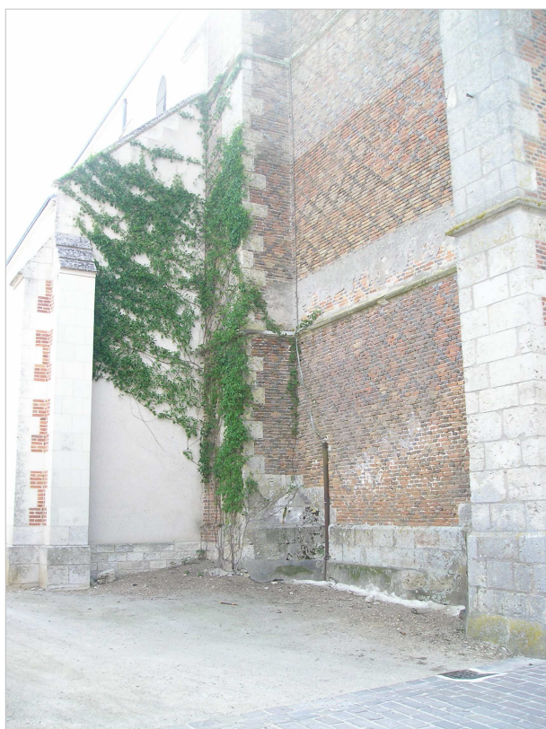
Photo 67 : Aire au bas de l'église laissée à nue et lierre grimpant, rue de l'Église.
