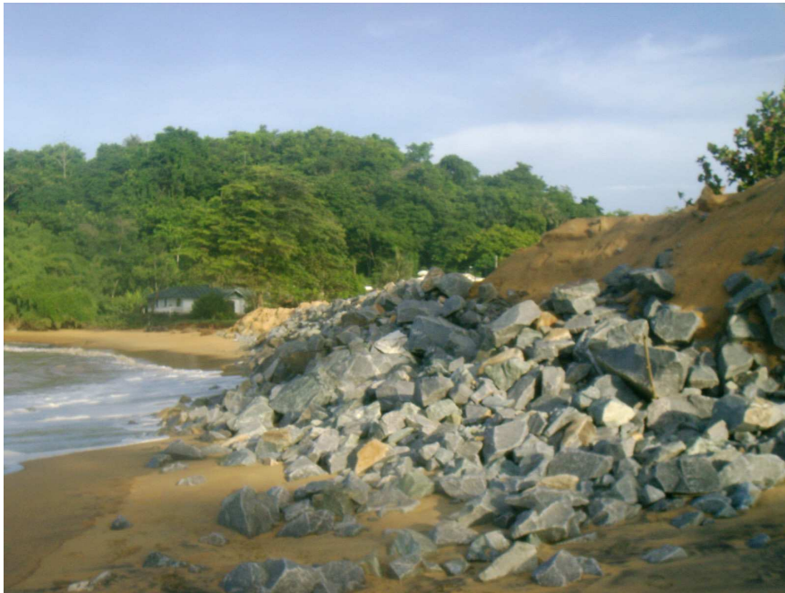
fig.18: Enrochement sauvage
