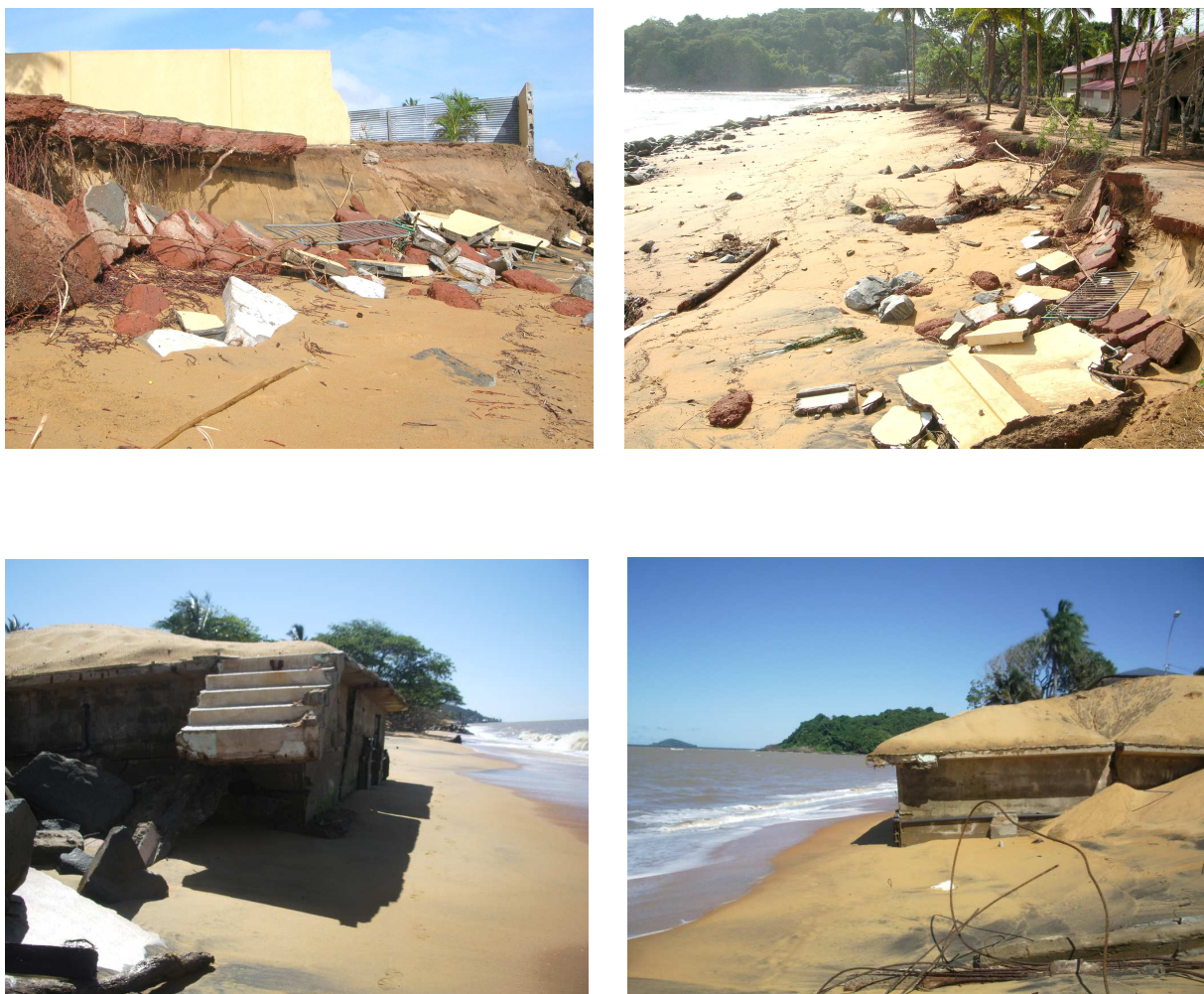
Fig.13 à 17: Conséquences de l'érosion sur les habitations et les équipements
