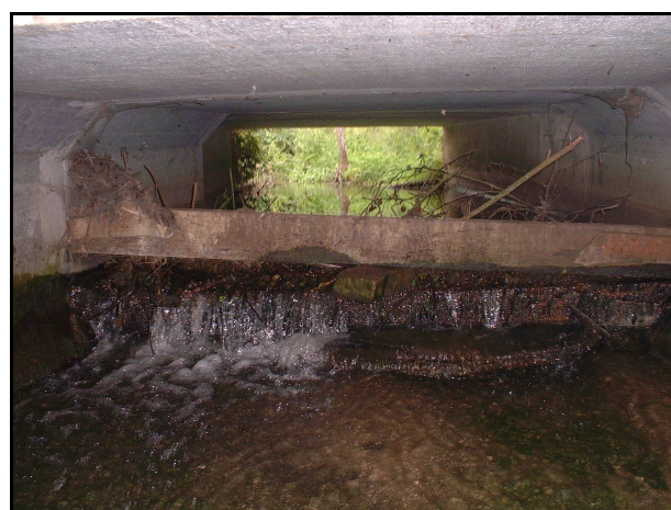
Figure 12. Seuil situé sur le ruisseau du Gradon
