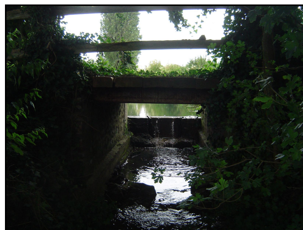
Figure 14. Seuil situé sur le ruisseau de la Varichaudun
