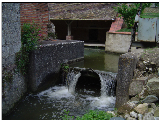
Figure 13. Clapet hydraulique situé sur le ruisseau du Valmer
