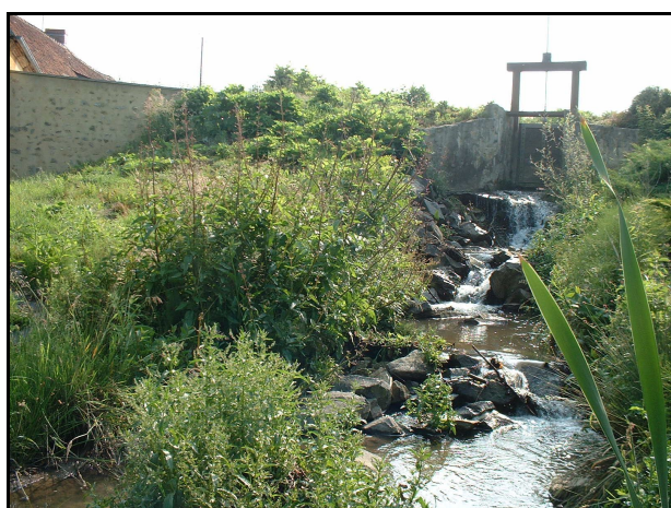
Figure 11. Ouvrage vanne situé sur le ruisseau du Gradon
