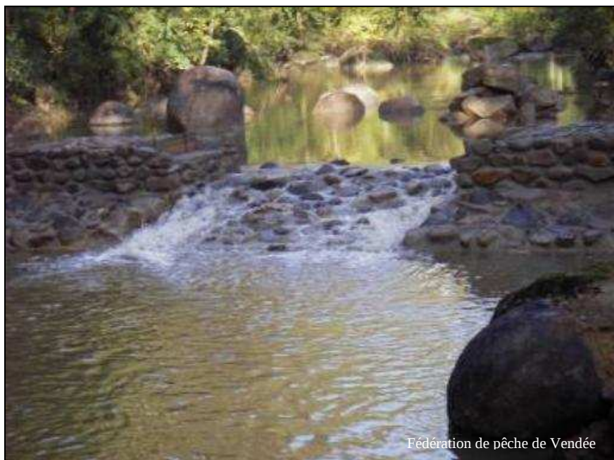
Figure 40 : photographie d'une passe rustique en pierres maçonnées
