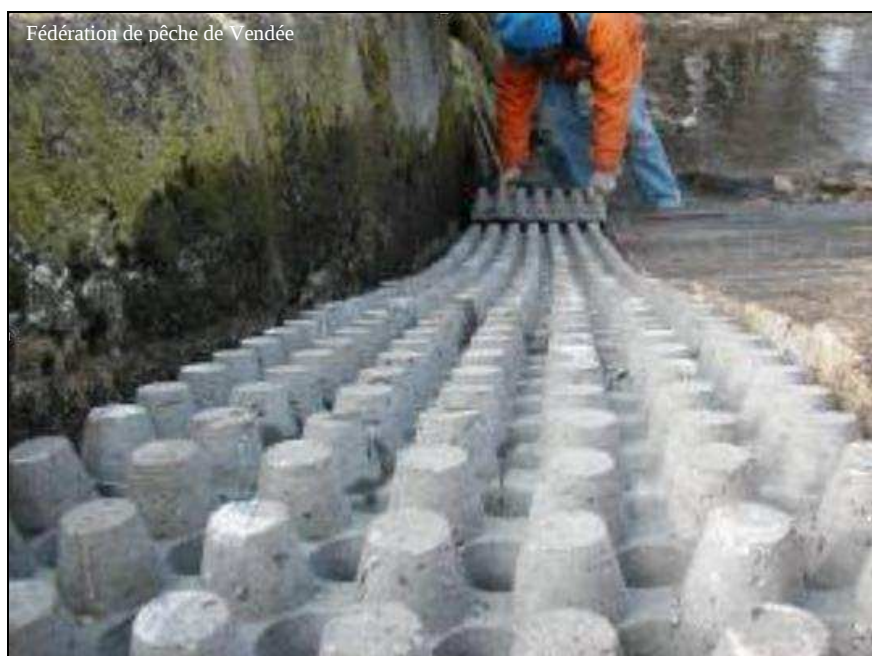
Figure 41 : Photographie de la pose de plaques Evergreen
