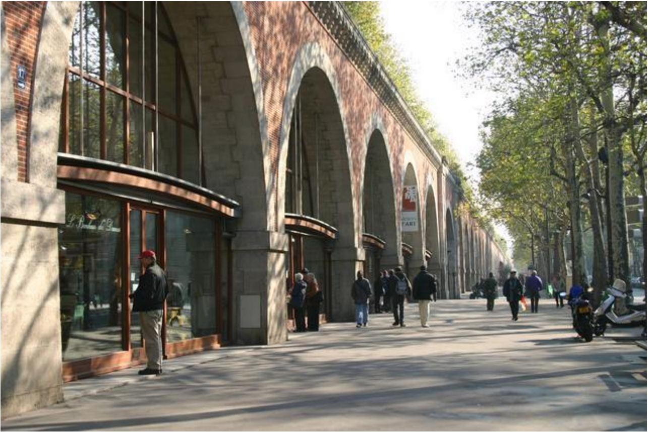
Le viaduc des Arts à Paris
