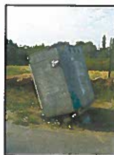
Container à verre ouvert et déplacé rue Matisse
