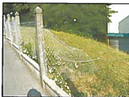
Clôture détériorée, rue G. Courbet à proximité de la crèche des galopins
