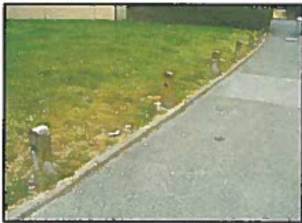
Barrière dégradée sur le Haut Blum
