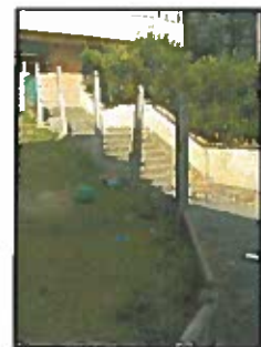
Barrière dégradée à proximité de l'ancien centre social
