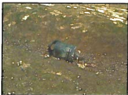
Corbeille descellée dans un fossé du parc Gauguin
