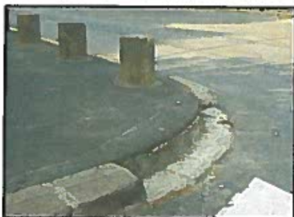
Bordure de trottoir endommagée au croisement de l'avenue L. Blum et de la rue Charles de Gaulle
