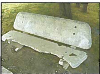
Banc dangereux en béton dans le parc Gauguin
