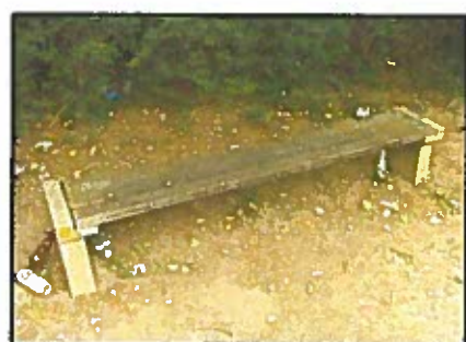
Banquette en mauvais état sur le secteur de l'OPIEVOY
