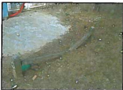
Barrière brisée à l'arrière de la tour 38 de Logement Français (29, avenue L. Blum)
