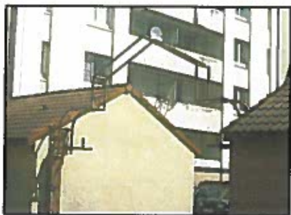
Portique hors d'usage à l'entrée des boxes des 1 et 3 rue P. Gauguin
