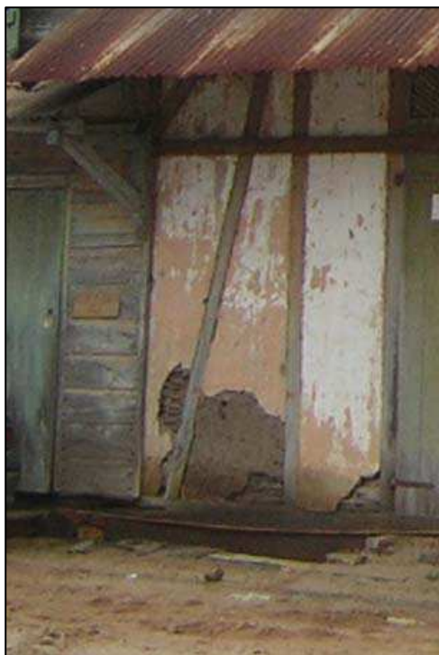
Photo n°79 : Torchis sous enduit
