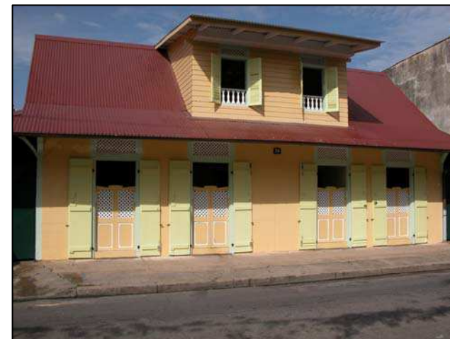
Photo n°14 : R.D.C. + combles aménagés Source : YVON LENTIN, S.D.A.P.
