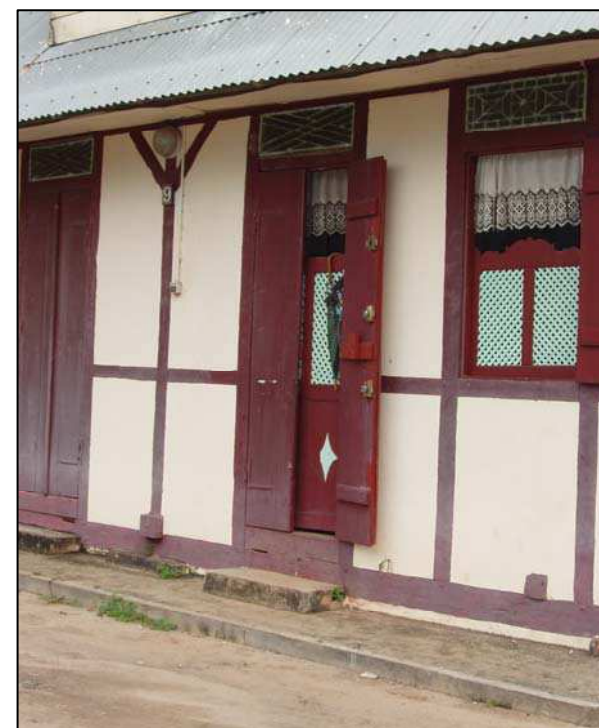
Photo n°90 : Percements au rez-de-chaussée
