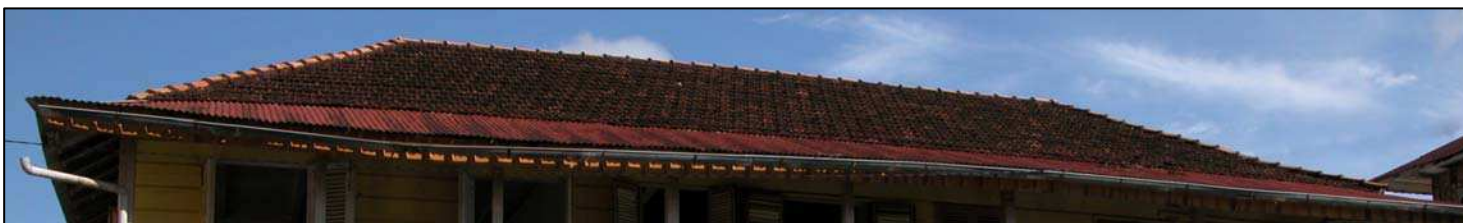
Photo n°9 : Tuiles en terre cuite
