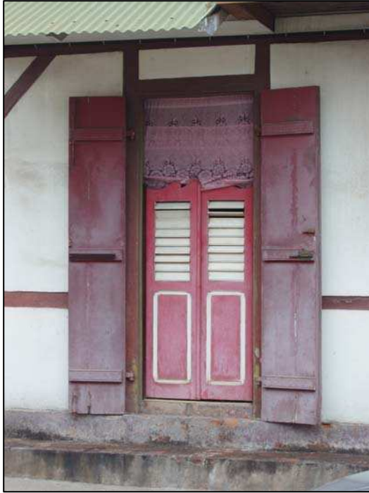
Photo n°40 : Porte peinte à deux battants de bois avec ventelles semi-fixes, avec des volets pleins
