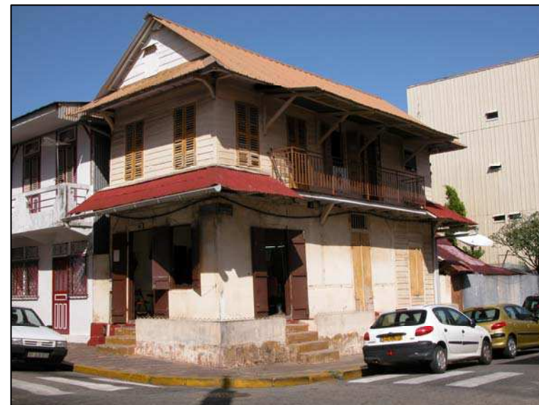
Photo n°27 : Toit à deux pentes avec retour en pignon Source : YVON LENTIN, S.D.A.P.
