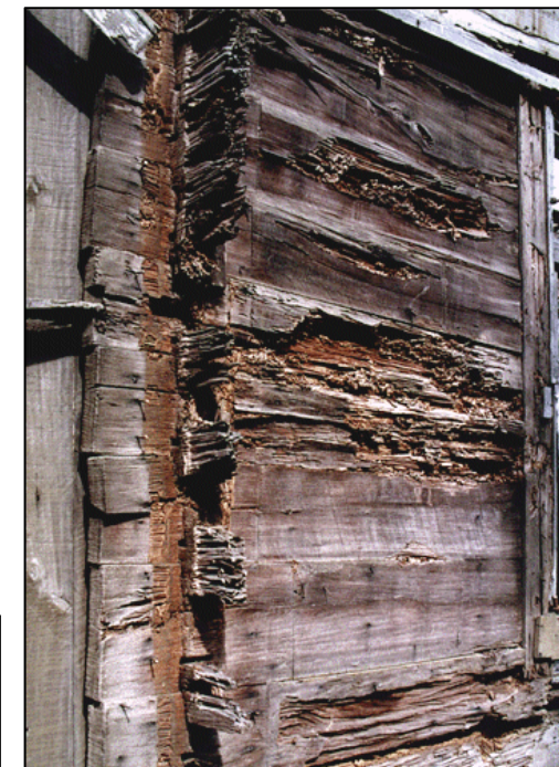
Photo n°2 : Dégâts occasionnés par des termites sur des clins en bois
