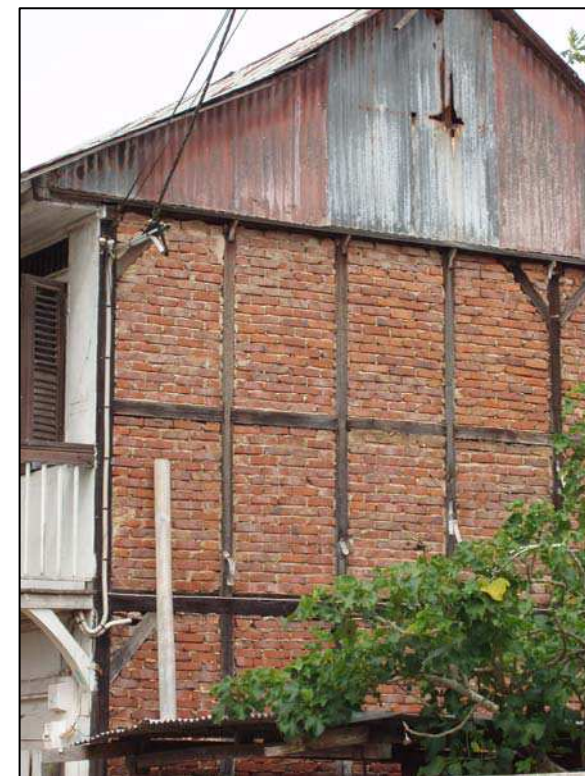
Photo n°81 : Remplissage en briques creuses d'une maison à étage
