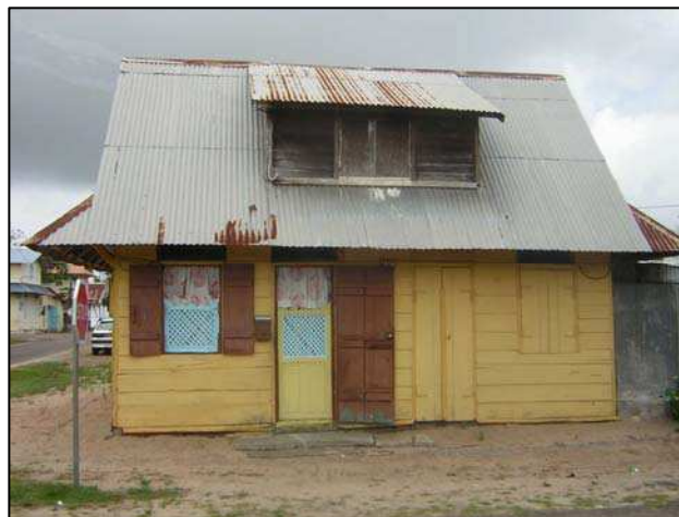
Photo n°77 : R.D.C. + toit + combles aménagés
