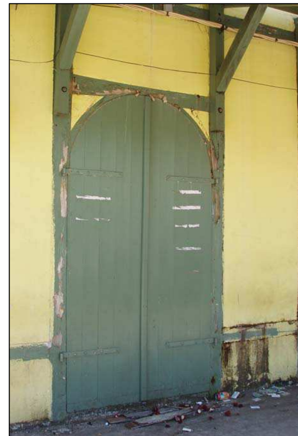
Photo n°21 : Un arc tendu servant d'ossature à un percement au rez-de-chaussée
