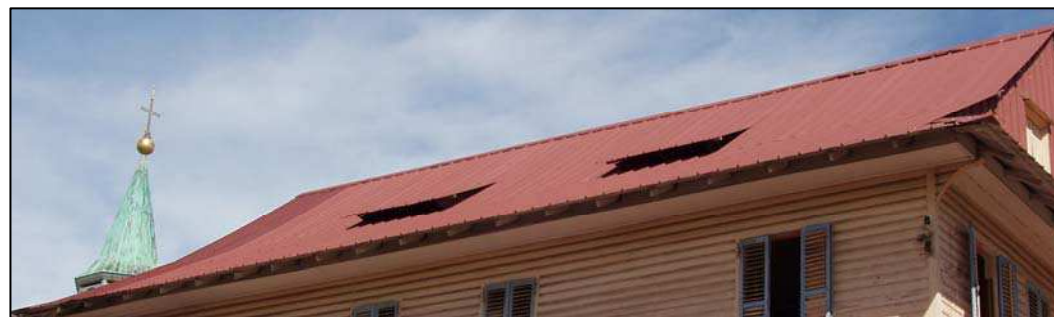
Photo n°39 : Deux Relevés sur un toit en tôles ondulées
