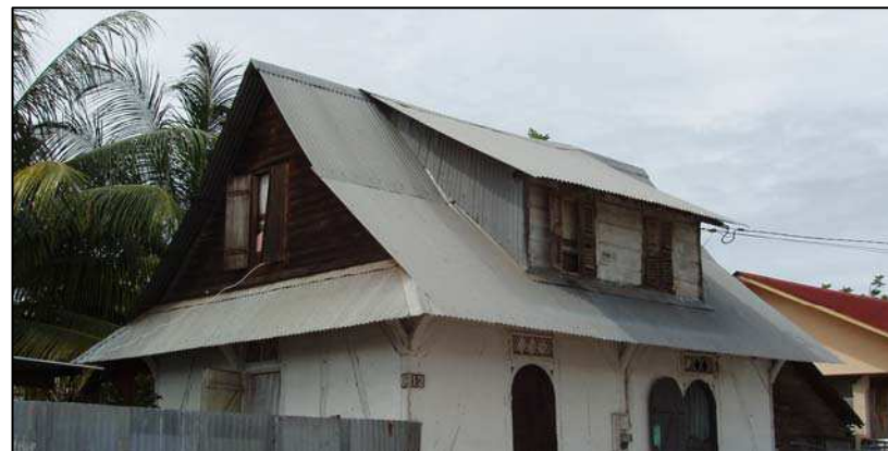
Photo n°85 : Toit à deux pentes avec retour en pignon
