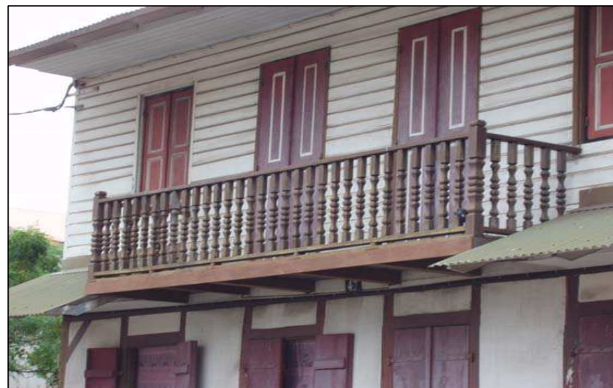
Photo n°55 : Balcon avec un garde-corps en bois à barreaux tournés
