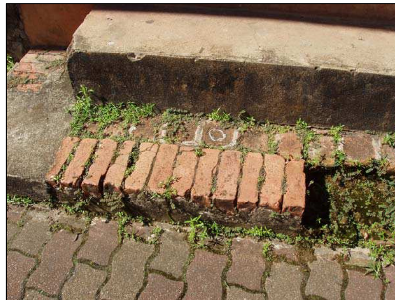
Photo n°4 : Briques pleines pour les marches de l'assise
