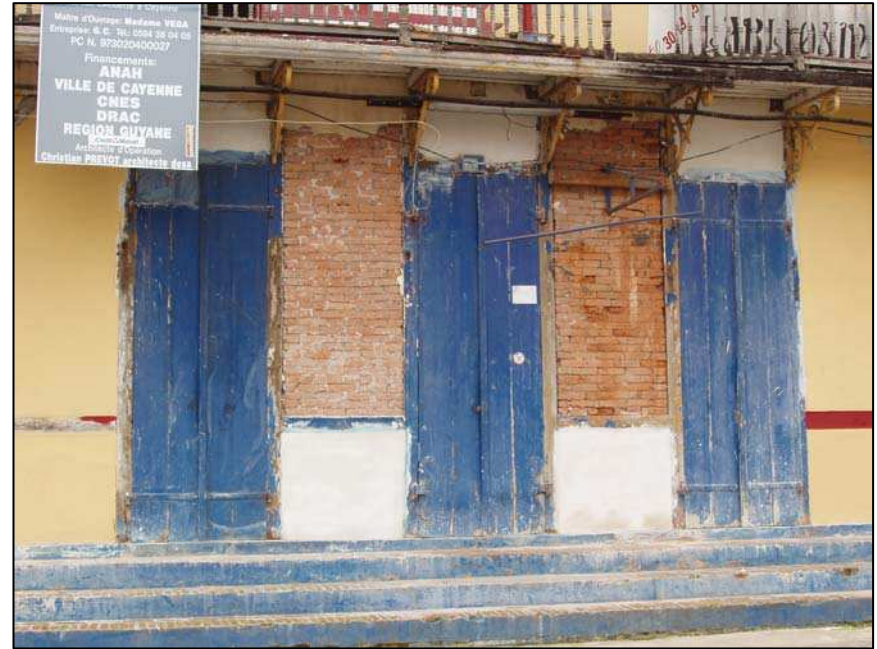
Photo n°23 : Remplissage en brique pleine au rez-de-chaussée d'une maison en pleine réhabilitation
