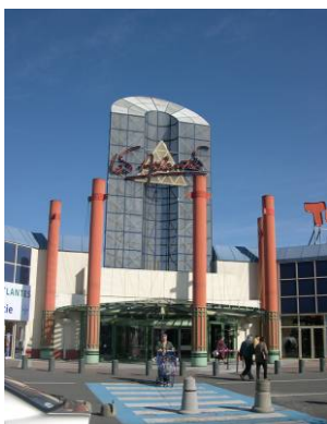
Photo 21: Entrée du centre commercial
