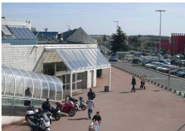
Photo 24: Entrée du magasin et accès au parking sur dalle
