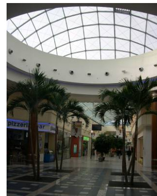
Photo 15: Puits de lumière central
