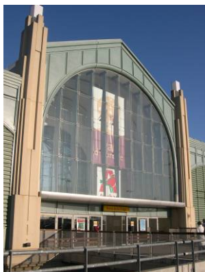
Photo 7: Entrée du centre commercial
