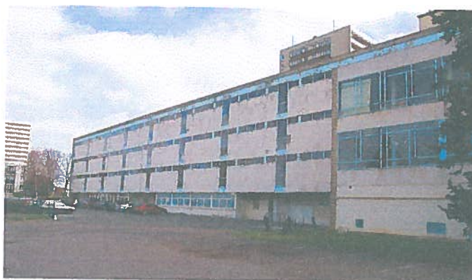
Fig.14 et 15 « Aile fille » côté Ouest
