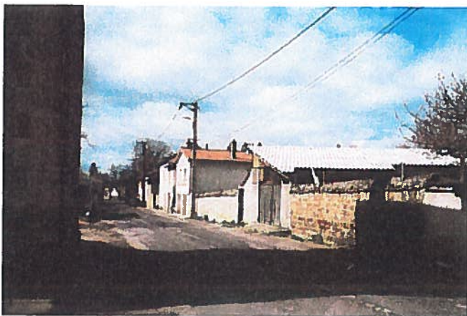
Photo 35 : Rue Charles Fabre
