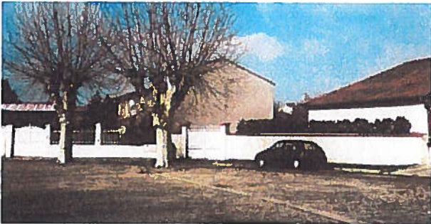
Photo 29 : Pavillons plus récents, au nord-ouest
