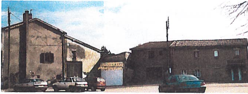
Photo 28 : Habitations à réhabiliter au sud de la place
