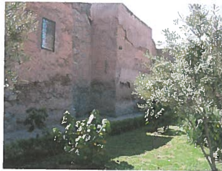
photo 35 : Intégration dans le tissu traditionnel bâti
