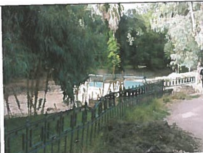
photo 33: mobilier en mauvais état dans le 'Jnan Sbill'
