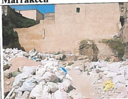
photo 72 : terrain déblayé du projet 'R'Cif'
