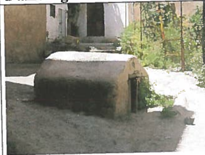
photo 15: "meda", système de distribution d'eau traditionnel
