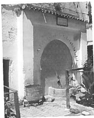
photo 41: Réhabilitation d'une fontaine traditionnelle
