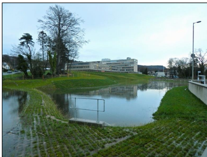
Figure 20 Exemple d'étang de stockage à Garshake, source : geograph.org.uk
