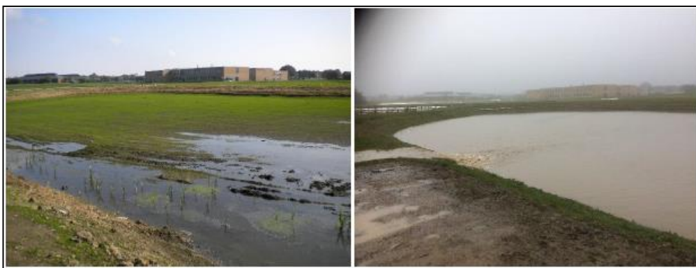
Figure 10 Bassin de rétention du lycée de Longbenton, Source: Susdrain.org
