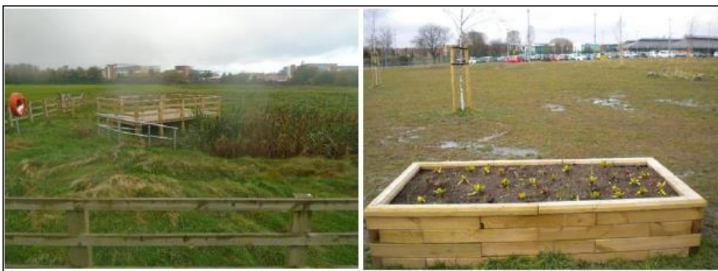
Figure 11 Exemple d'aménagements éducatifs construits à Killingworth, Exemple Susdrain.org
