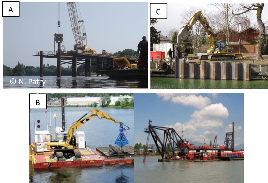
Figure 7 : Exemples de travaux pouvant être menés en rivière. A : Vibrofonçage (Source : Biotope). B : Dragage (Source : Les altérations anthropiques du transport solide, Office Français pour la Biodiversité). C : Fonçage de palplanches (Source : SGC Travaux Spéciaux)
