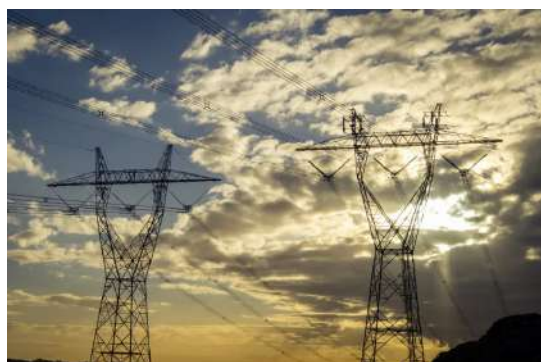
Figure 8 : Exemple de lignes électriques courantes et visibles dans le paysage.
