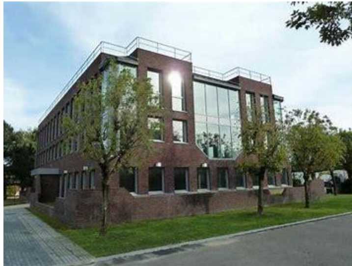
Figure 22 : Photo de l'opération Velizy Green
