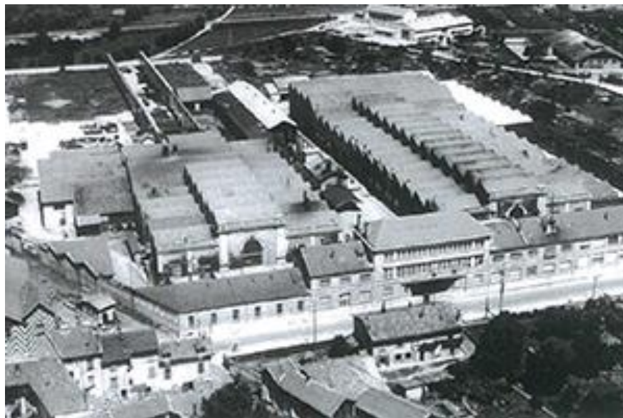
Figure 29: Ancienne usines Neyrpic. Source : Neyrpic.fr
