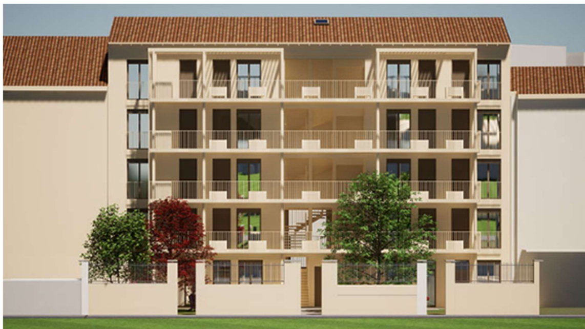
Figure 4 - La Maison de la Diversité à Lyon (69)
