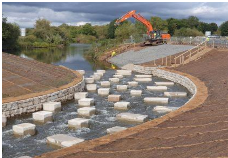
Figure 14 : Construction de la passe à poissons de Bevere (Source : Crundwell)
