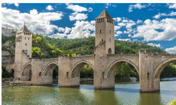
Figure 1 : Le pont du diable de Cahors Source : photononstop - Danièle Schneider
