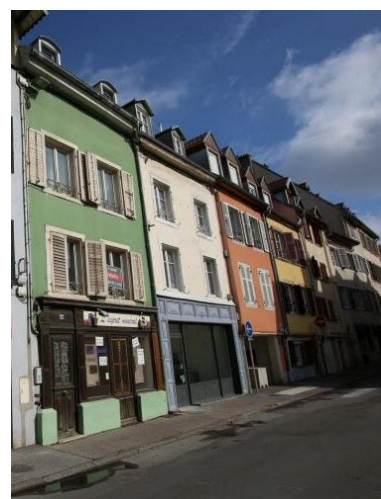
Figure 51 : Campagne de ravalement de façade dans le secteur à valeur patrimoniale Source : estrepublicain.fr
