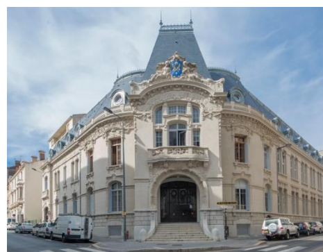
Figure 73 : Réhabilitation de l'immeuble de la Condition des Soies en logements à Saint-Etienne (2012) Source : metalconcept.fr
