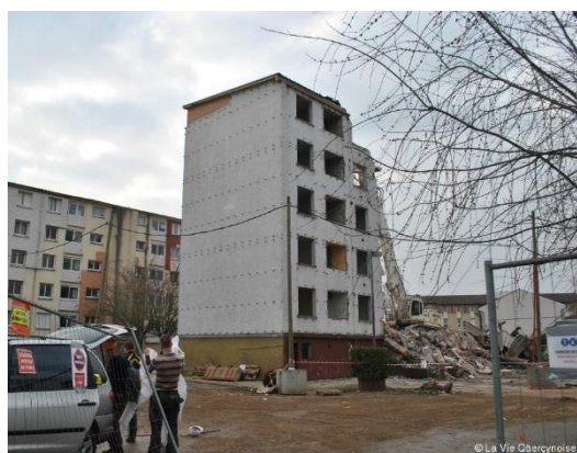
Figure 28 : Démolition de logements sociaux du quartier de la Croix de Fer à Cahors
