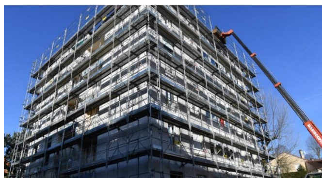
Figure 29 : Rénovation thermique des logements de Lot Habitat dans le quartier de Sainte-Valérie, à Cahors (2020)
