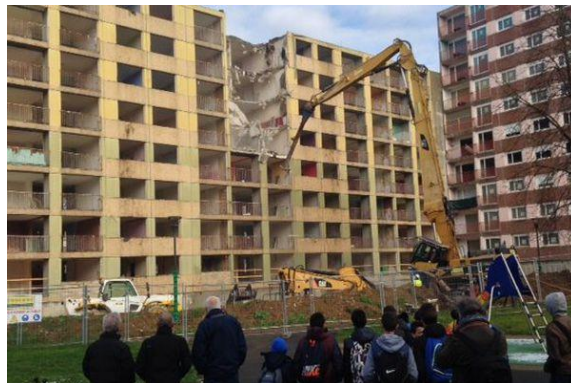
Figure 50 : Démolition à la Petite Hollande, à Montbéliard Source : france3-regions
