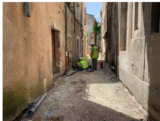
Figure 25 : Rénovation des ruelles du centre ancien de Cahors (2019) Source : medialot.fr
