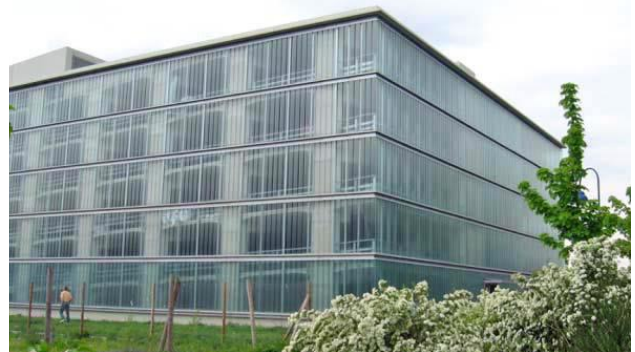
Figure 15 : Garages collectifs, Vauban-Fribourg. Source ARENE Ile-de-France & IMBE (2005)
