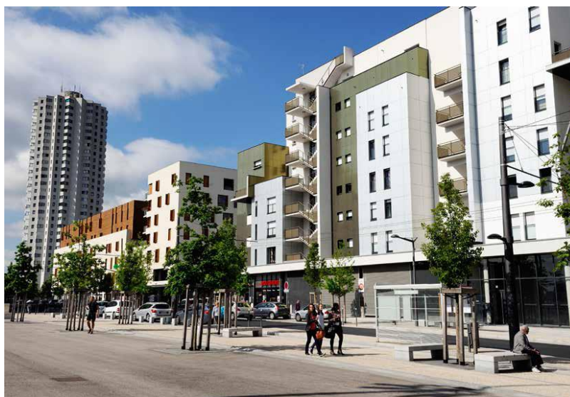
Figure 47 : La Duchère à Lyon, Source : GpvLyonDuchère, 2016
