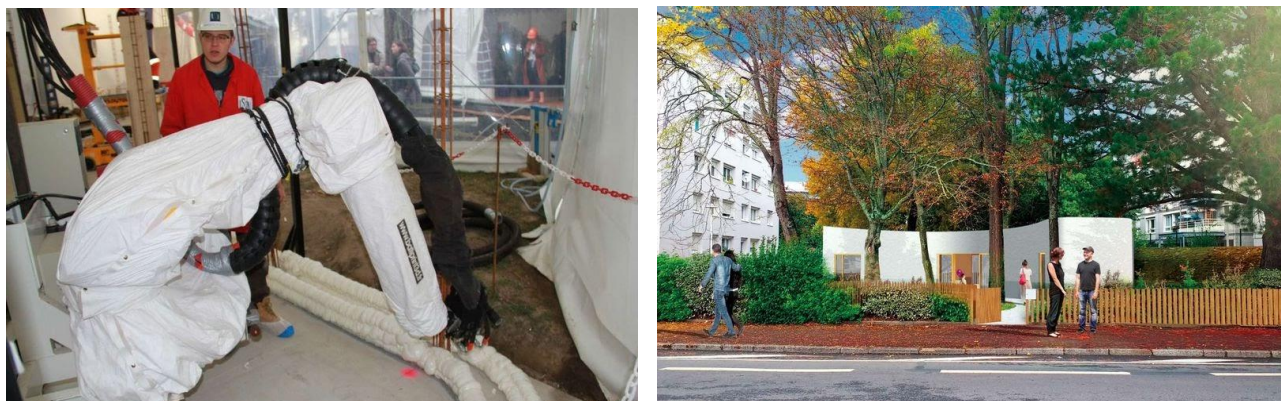
Figure 23 : Une maison imprimée en 3D à Nantes, Source : Aphadolie (2017), Bâtiprint : Une maison imprimée en 3D à Nantes
