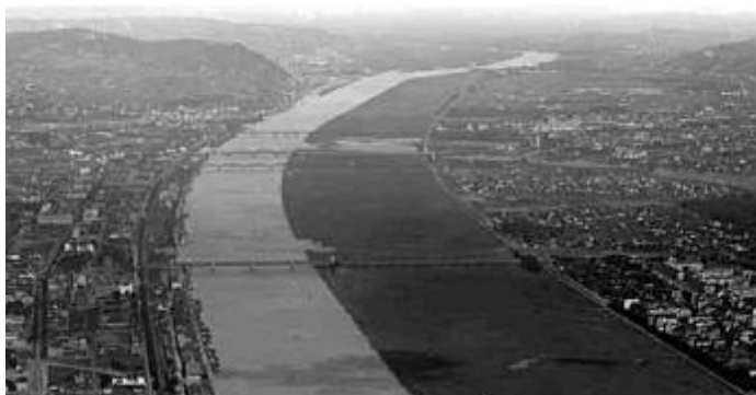
Photo 20-Le Danube après la première phase de régulation
