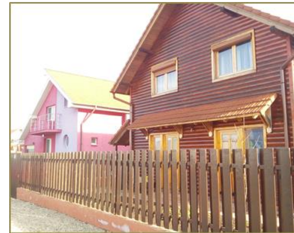
Figure 22- Photo de maisons à Grigorescu (source : Alcine Ferraris & Florian Lallart)
