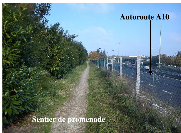
Figure 34: Sentier de promenade sur la crête de la digue du Canal
