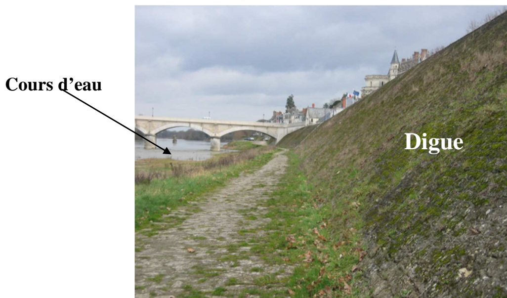
Figure 4: Digue d'Amboise (Val de Loire), digue de premier rang.
