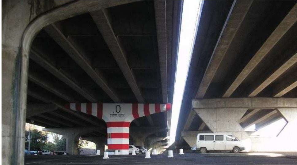
Figure 35: Point zéro situé sous l'autoroute A10.
