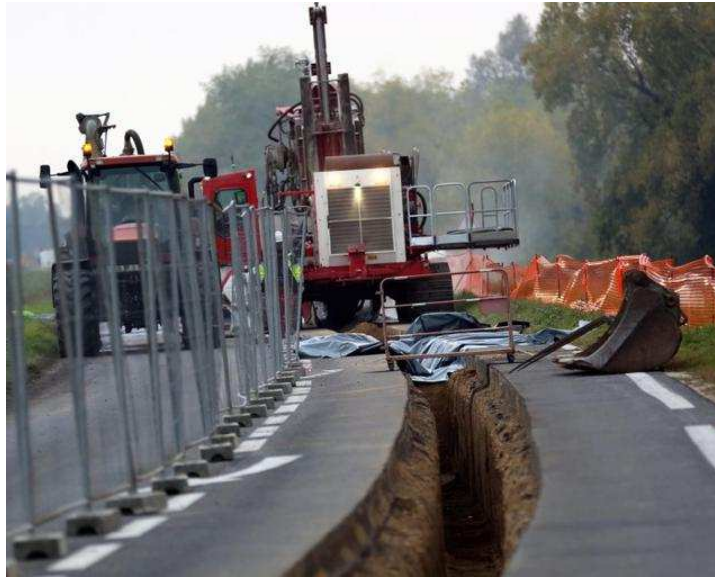
Figure 23: Travaux de renforcement de la digue à Saint-Pierre-des-Corps.
