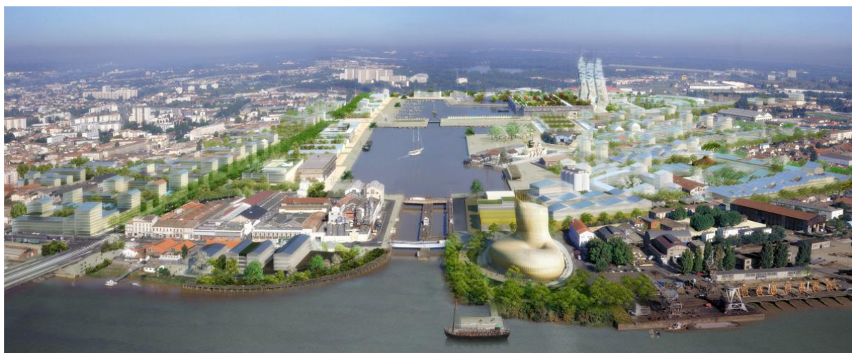
Photo 10 : Vue de l'opération Bassin à flots
