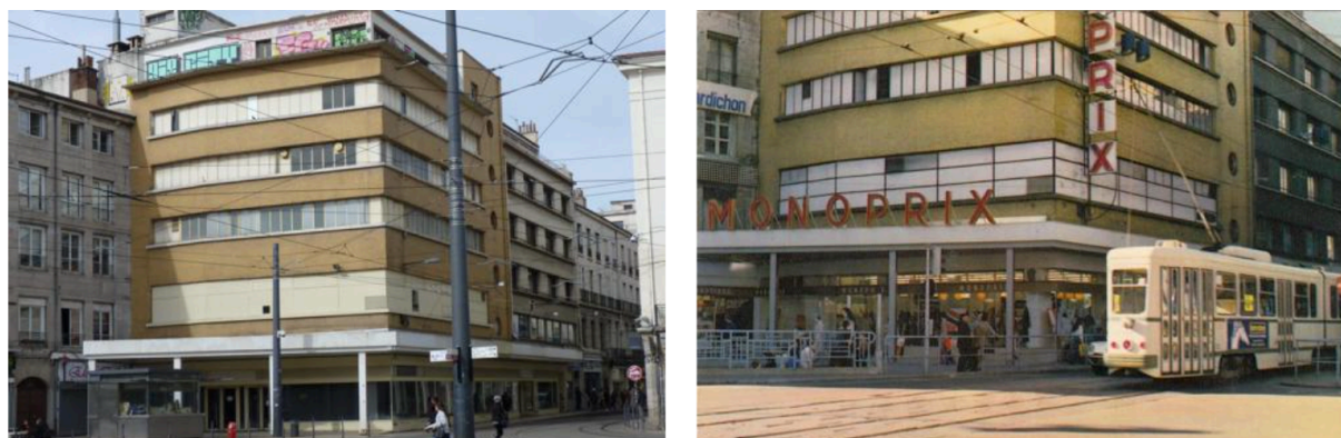
Photo 8 : L'immeuble Monoprix actuellement et à l'époque où Monoprix était encore installé
